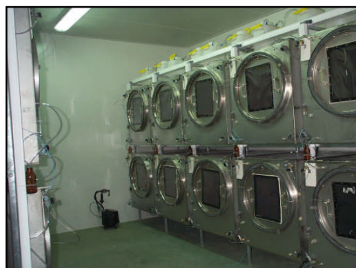
System kontroli atmosfer Oxystat 2 i kontenery do przechowywania owoców w CA i ULO
