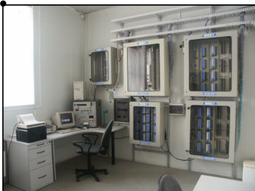
System kontroli atmosfer Oxystat 2 i kontenery do przechowywania owoców w CA i ULO
